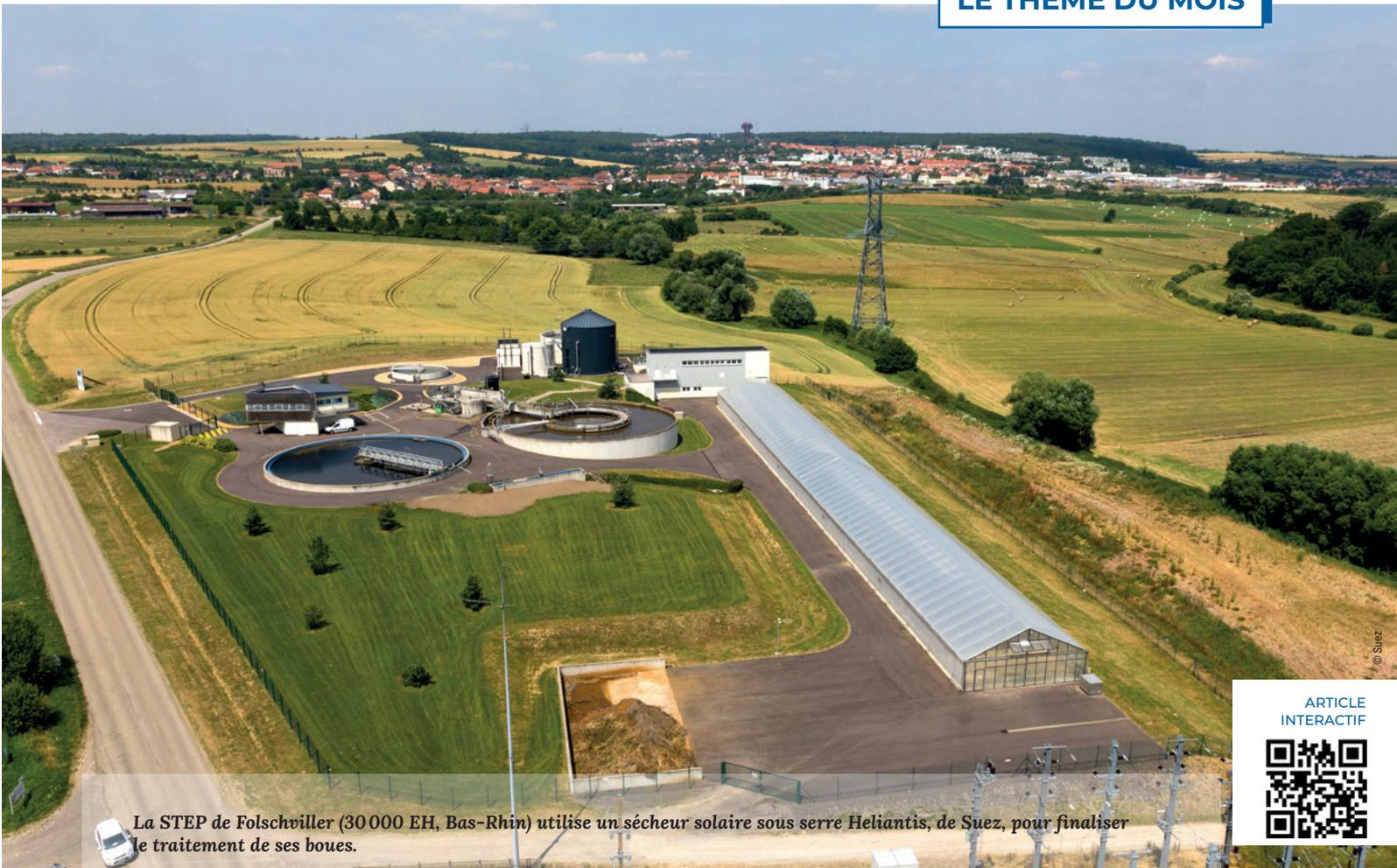
La STEP de Folschviller (30 000 EH, Bas-Rhin) utilise un sécheur solaire sous serre Heliantis, de Suez, pour finaliser le traitement de ses boues.
