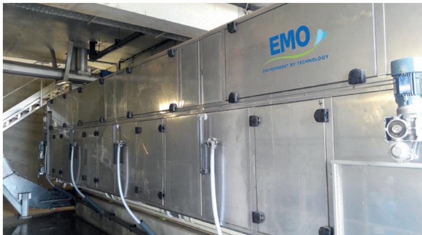
EMO a installé un sécheur à très basse température à air pulsé Watromat® à la STEP de l'Aiguillon-sur-Mer (18 000 EH, Vendée).
