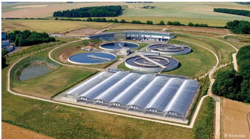
Le procédé Tersolair installé sur la STEP de Chartres par Aqualter permet de traiter 2000 TMS/an par séchage solaire.
